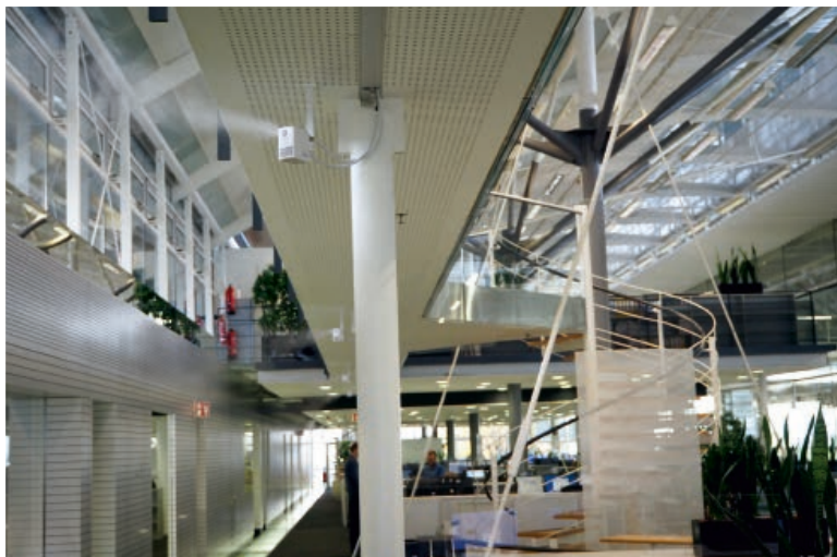
Bild 1 und Bild 2 • Die seele GmbH hat in den Büroräumen am Stammsitz in Gersthofen eine Direkt-Raumlufftbefeuchtung nachgerüstet, die eine Luftfeuchte von 45 % sicherstellt.
