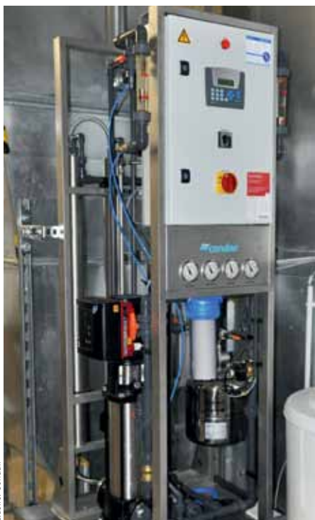
Umkehrosmoseanlage im Bundesratsgebäude
